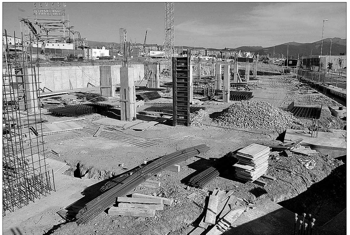
Estado actual de las obras de la futura biblioteca pública, en el nuevo barrio de Ciudad y Tierra de Segovia. / A. BENAVENTE
