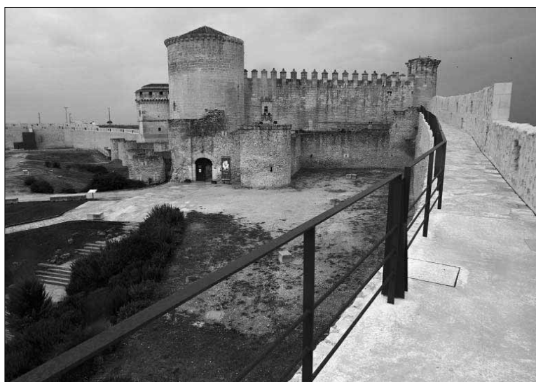
Los trabajos se llevarán a cabo en el interior del Castillo./GABRIEL GÓMEZ
