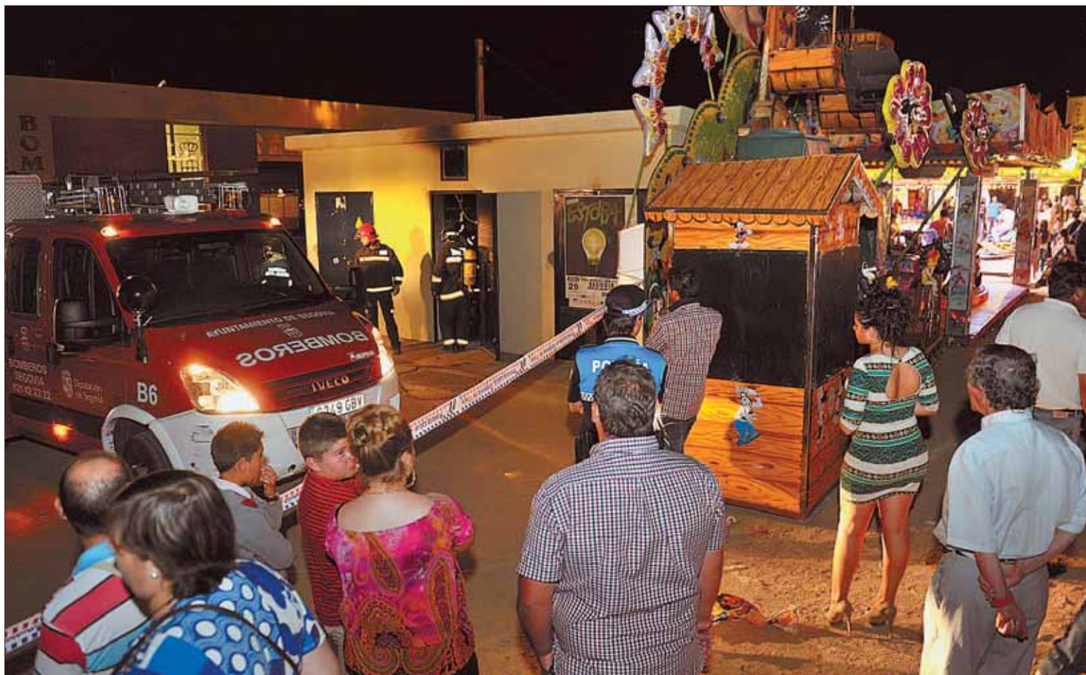
Los bomberos acordonaron la zona próxima al transformador una vez sofocado el incendio que inutilizó sus equipos técnicos. / KAMARERO
