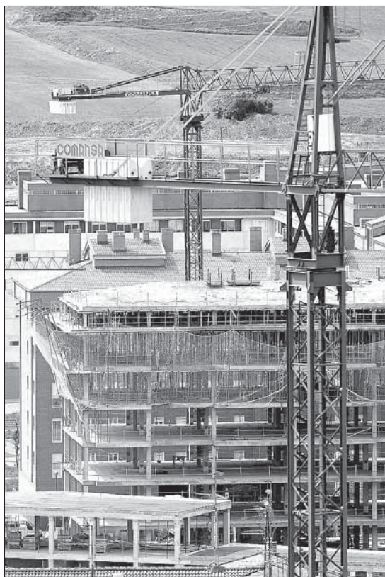
Viviendas en construcción en una ciudad española. / LUIS LÓPEZ ARAICO
