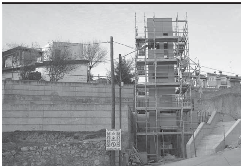
El ascensor del Centro de Día, más cerca. El ascensor de acceso al Centro de Día desde la calle Hojalatas podría iniciar su funcionamiento a comienzos de febrero tal y como señaló la alcaldesa, Marisa González. Ayer se inició la colocación de la maquinaria del ascensor tras la que se instalarán los paneles exteriores, y restan también las luminarias en las escaleras las cuales están ya concluidas. / FOTO: GABRIEL GÓMEZ
