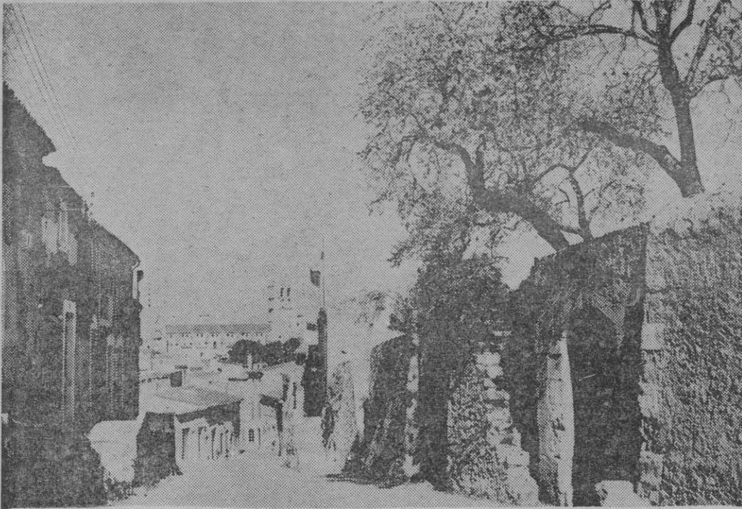
La parte alta de nuestra ciudad, pronto contará con un regular servicio de agua corriente. — (Foto Pascual)
