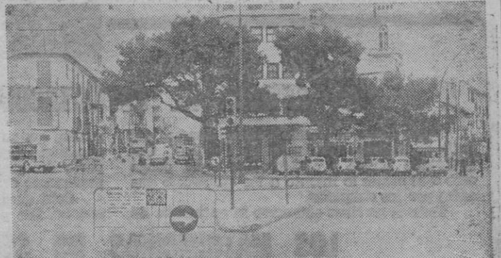
Plaza del Puente. Desembocadura de Andrea Doria, Espartero, Monseñor Palmer, Calvo Sotelo... Es difícil encontrar otro lugar menos adecuado para que la CTNE ande en obras.
