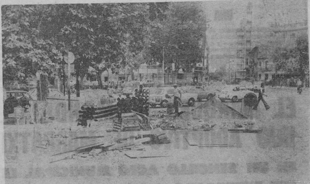
Obras en la Plaza del Progreso. Otra zona de congestión indiscutible en la arteria hacia el populoso Poniente de Palma.
