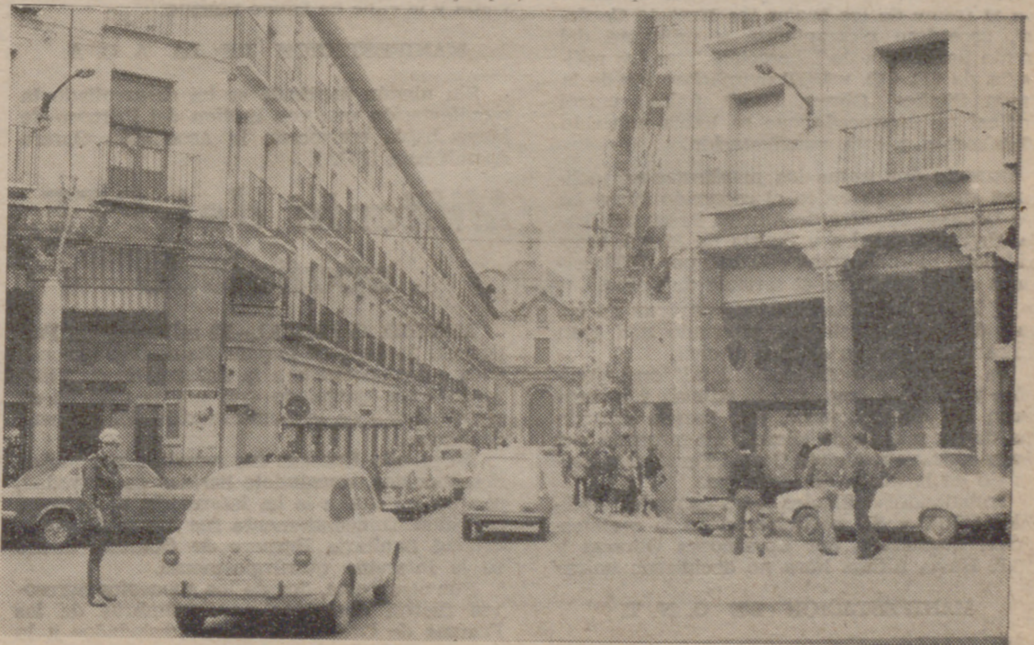
Calle de Platerías, intocada hasta ahora, una excepción.
