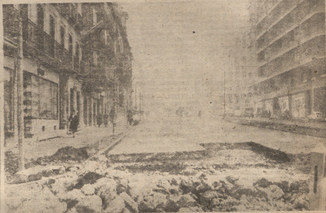
LA TRANSFORMACION DE LOS BULEVARES Iniciadas este verano, las obras de los bulevares—que parecían interminables, hasta el punto de ser objeto de la "inocentada" del año—parecen haber adquirido un buen ritmo. He aquí un aspecto del estado actual de las obras. (Fotofiel.)
