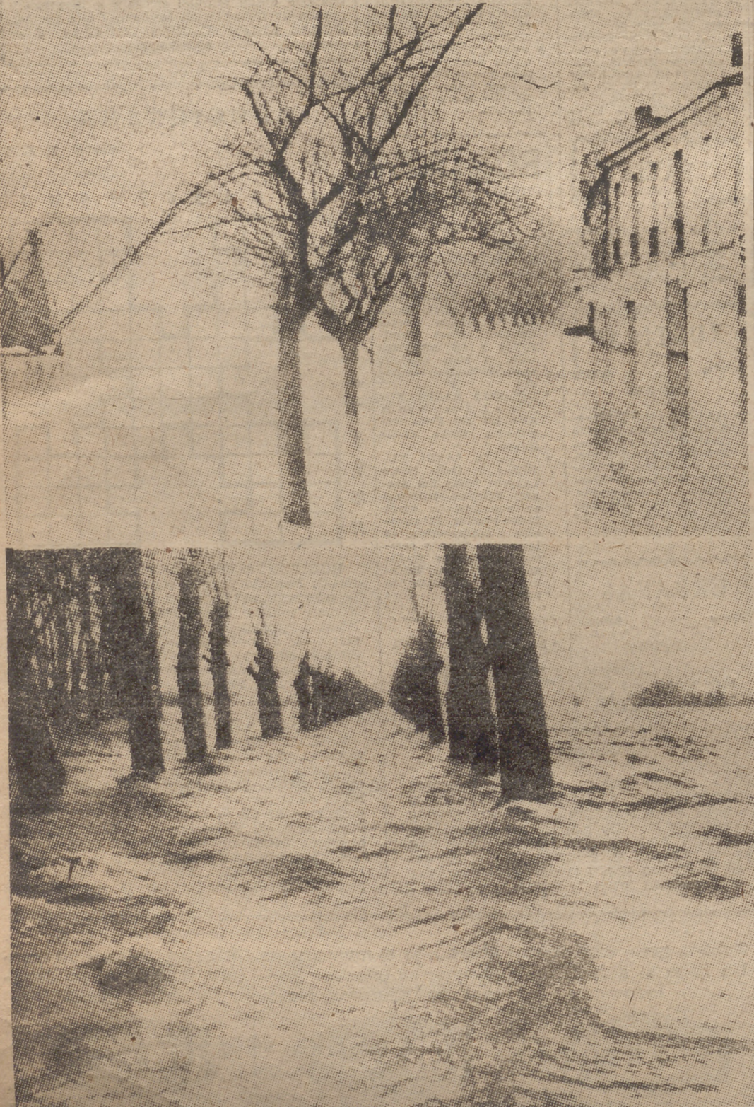
La crecida del río Garona, en Francia, causa grave inquietud en la cuenca de dicho río. Las fotografías recogen el desolador aspecto de la campiña de Marmande. Las tumultuosas aguas han ocasionado pérdidas enormes. La inundación afecta a una gran zona de aquella región. (Foto Keystone.)
