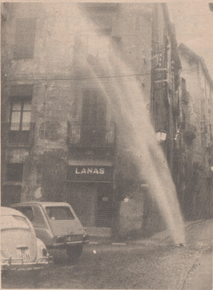
GERONA.— Un socavón en la calle de la Forsa provocó este surtidor que llegó hasta el piso cuarto de un edificio. —(Foto Europa Press).
