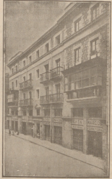
Fachada, por la calle de la Moneda, números 15 y 17, de la CASA SOCIAL propiedad de la Federación Burgalesa de Sindicatos Agrícolas Católicos.
