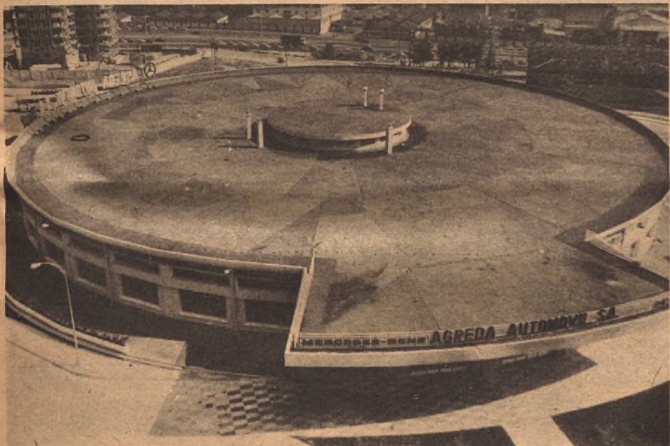
Las instalaciones vistas desde un plano superior
