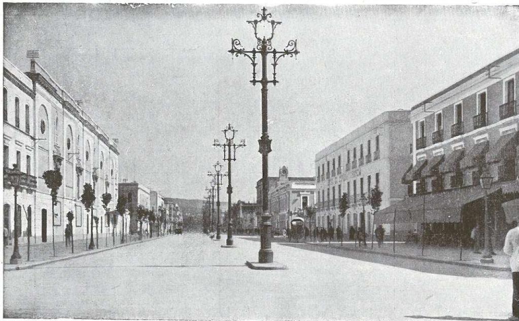
UNA MUESTRA DE PAVIMENTO DE LOSETAS DE ASFALTO COMPRIMIDO
