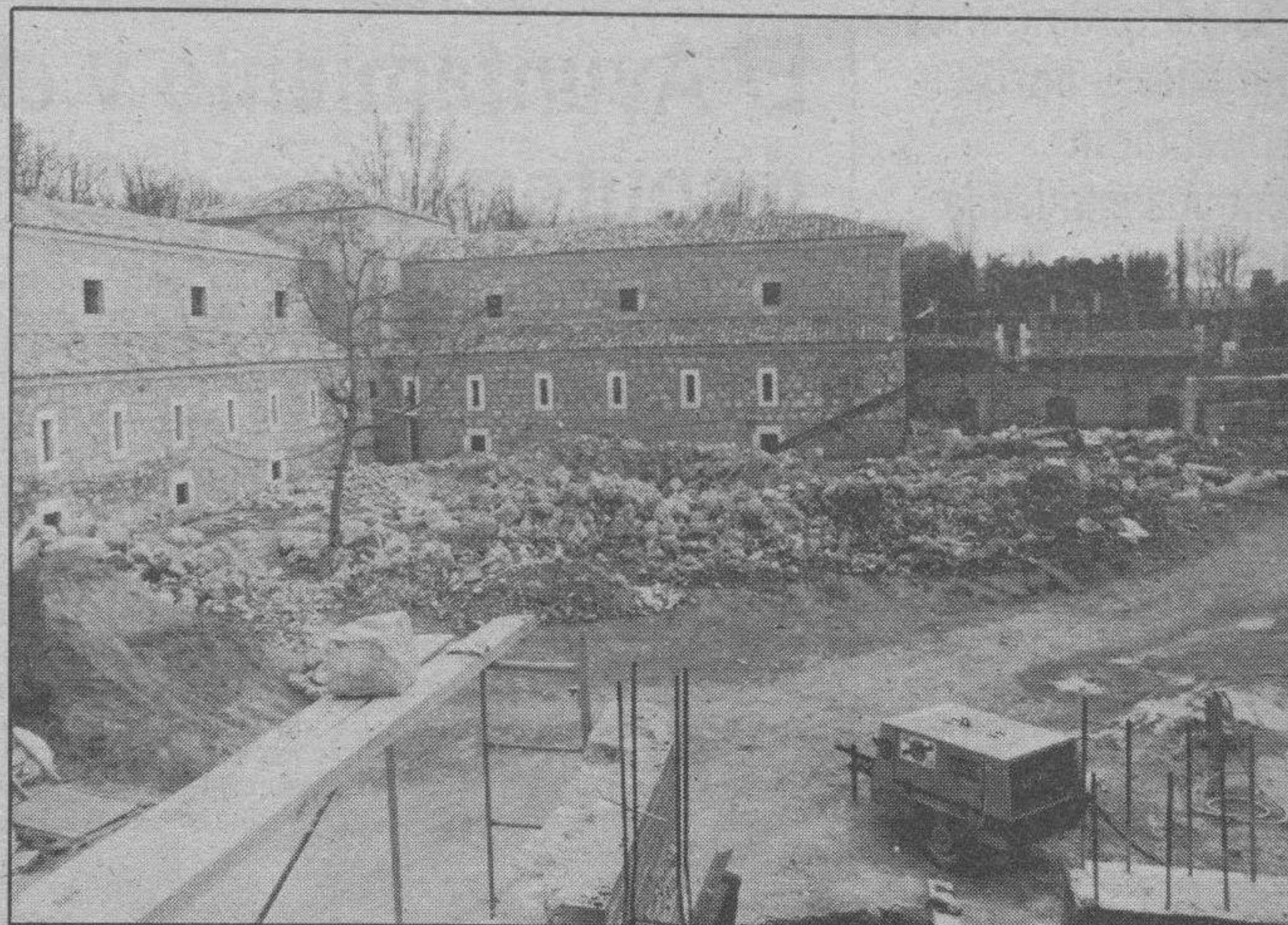
Obras de acondicionamiento del Hospital del Rey para instalaciones universitarias
