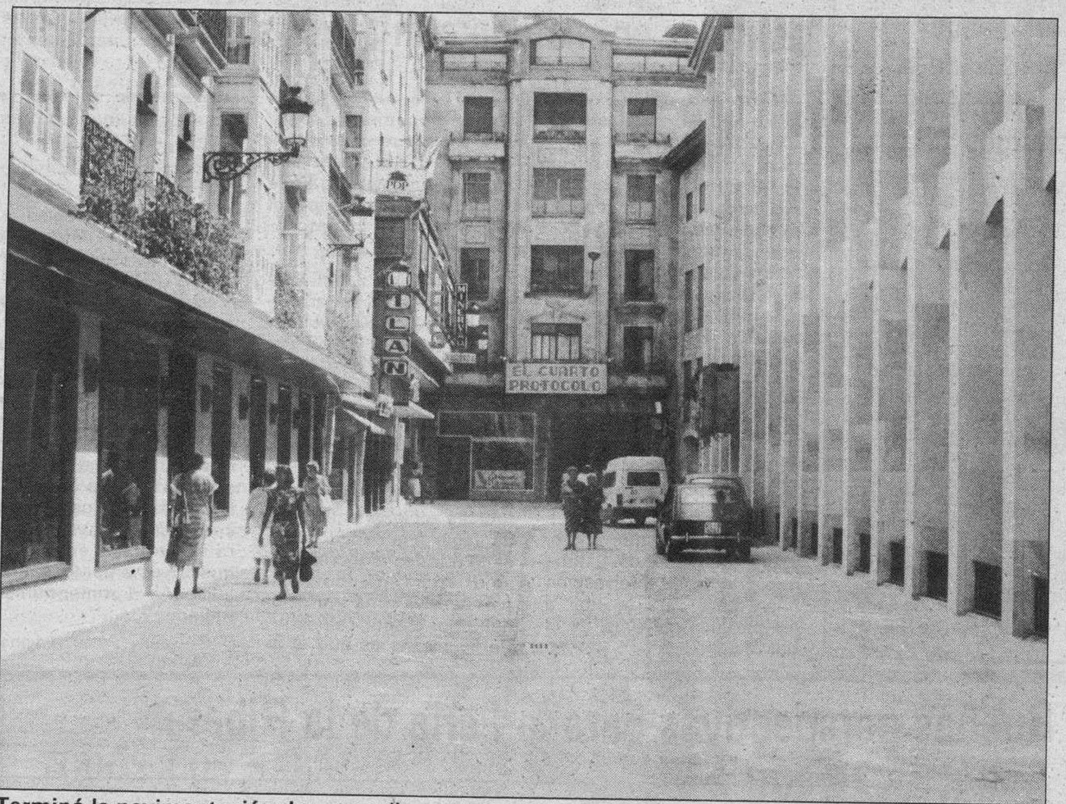
Terminó la pavimentación de esta calle. — Al fin concluyeron las obras de nueva pavimentación de la calle del Cordón, restableciéndose la normalidad en establecimientos y viviendas, así como en las entradas y salidas de las dos salas de proyección cinematográficas existentes en la misma vía pública, todos los cuales sufrieron con paciencia las inevitables molestias de estas obras que ahora han dejado el pavimento de la calle del Cordón en un estado satisfactorio.
