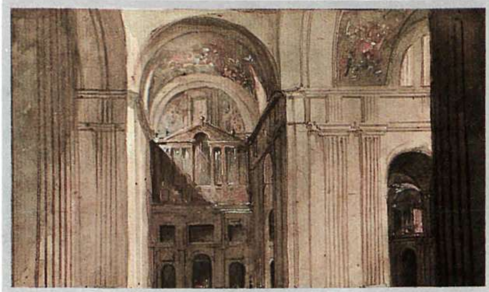
Interior de la iglesia. Capilla lateral derecha.
