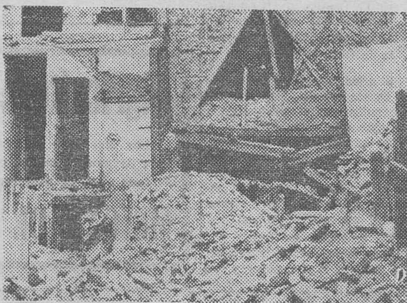
Aspecto que ofrece la edificación que ha quedado descubierta en el derribo de las casas de la calle de los Reyes Católicos, donde se aprecia una viga rota. (Foto Reyes)
