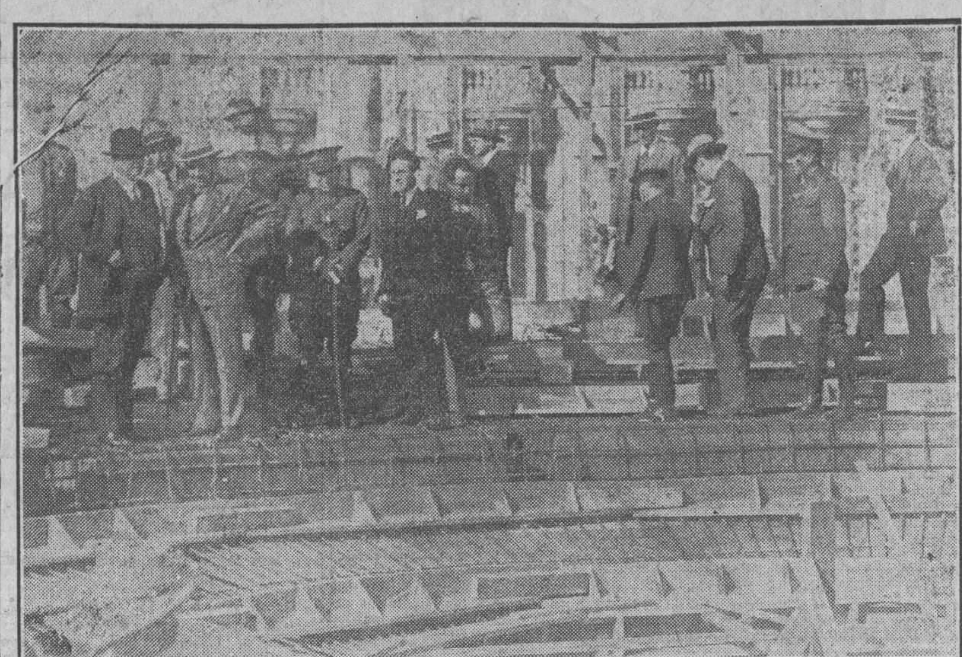
El Honorable Sr. Presidente de la República, visitó ayer las obras del Capítulo. Fué recibido por el personal técnico de la casa constructora Purdy and Henderson, y por los ingenieros del Departamento de Obras Públicas que tienen a su cargo la Dirección Técnica y Artística de las obras.
