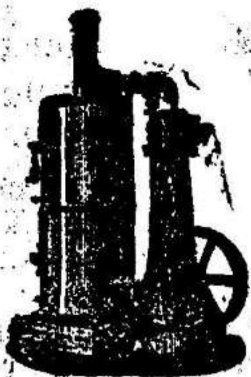
Máquina de vapor vertical.
