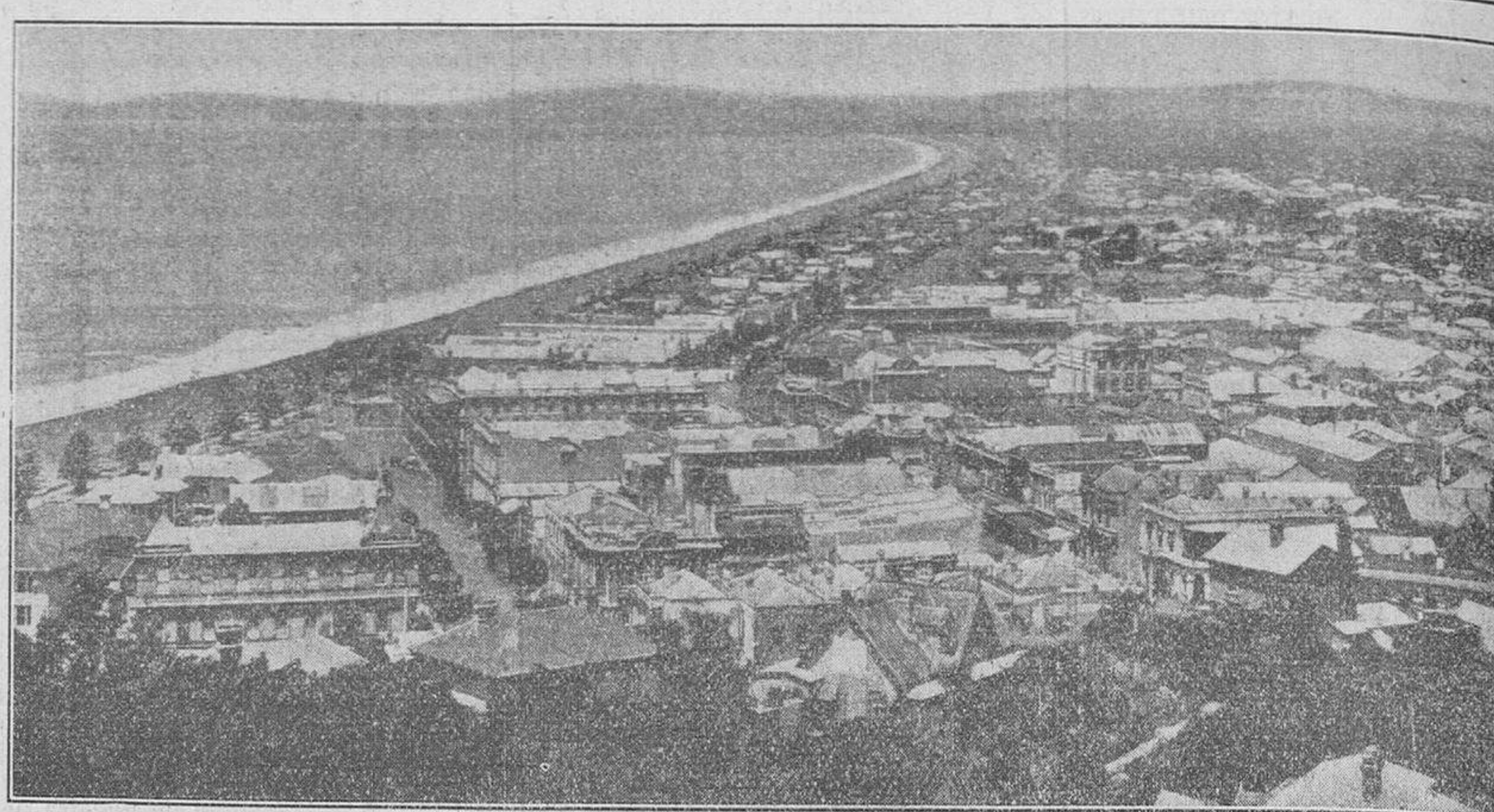
Nueva Zelanda.—Napier. Vista general de la ciudad, que ha sido totalmente destruida por un terremoto, que produjo numerosas víctimas.
