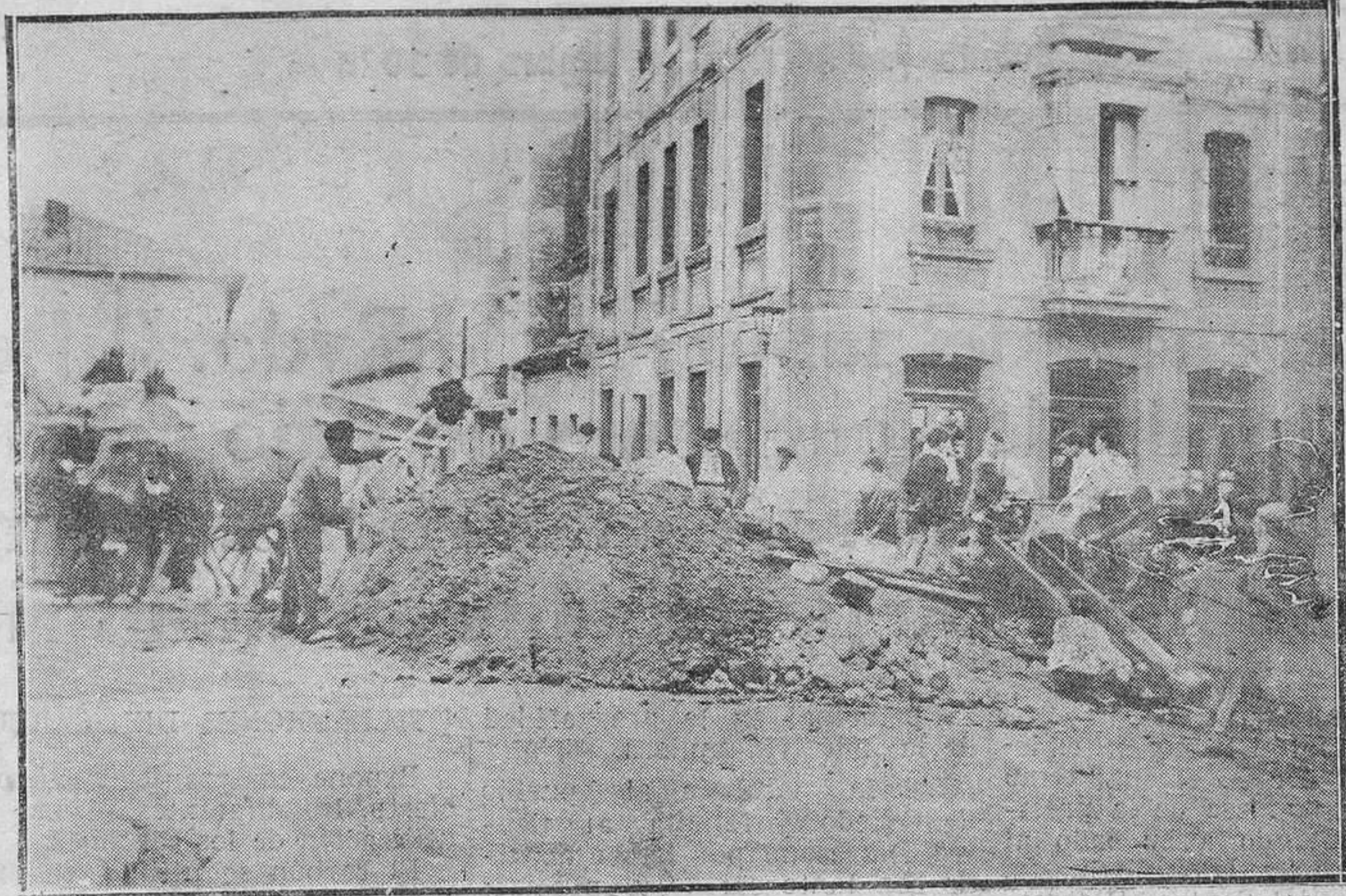
GIJÓN.—Las obras del alcantarillado. (Foto Mena).
