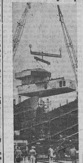
Sobre la cubierta de un destructor en construcción en un astillero norteamericano, desciende la parte del puente, previamente montada
