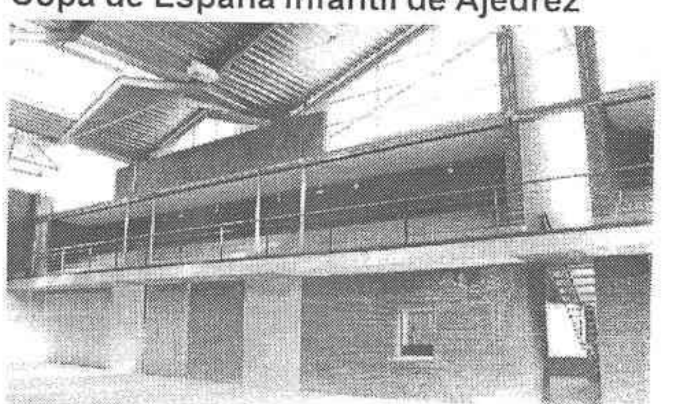
Pabellón Cubierto de San José
