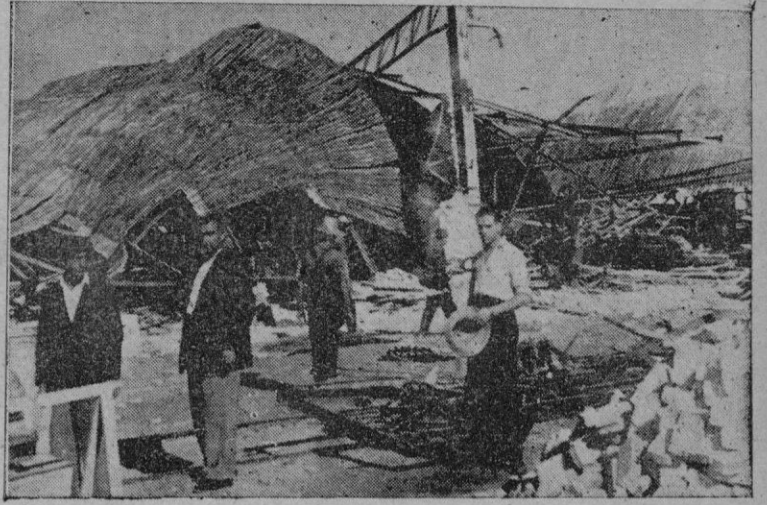
Los obreros trabajan ya intensamente en reparar los daños causados por la catástrofe en los asilleros gaditanos Foto Cifra Gráfica
