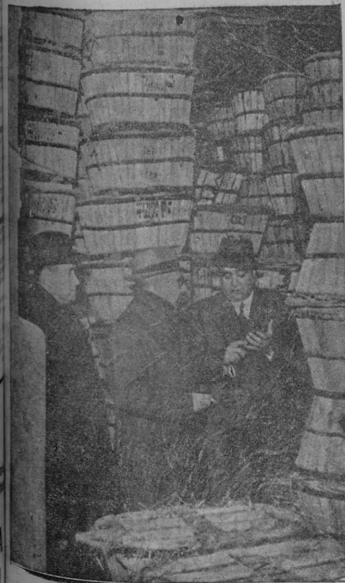
Madrid.— El ministro de Industria y Comercio, Sr. Suanes, visita los almacenes frigoríficos donde se guardan las carnes, frutas y verduras para el suministro de Madrid
