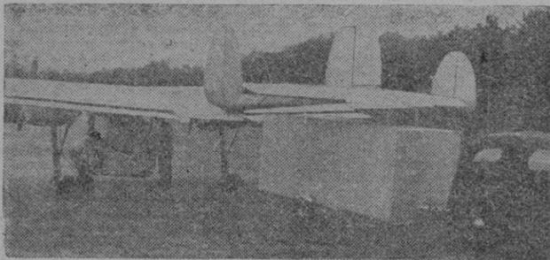
Un tipo revolucionario de un avión cuatrimotor para transporte de mercancías, en el cual el depósito de la carga puede soltarse y convertirse inmediatamente en remolque para la carretera. Ha sido construido por Miles Aircraft, Reading (Inglaterra). Se denomina Miles H. 68 y puede volar sin el depósito de la carga. La foto nos muestra el depósito de la carga convertido en transporte de carretera.
