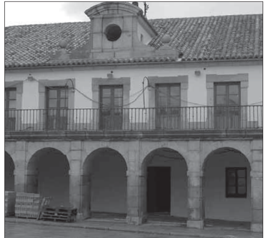
Fachada del Ayuntamiento de Villacastín
