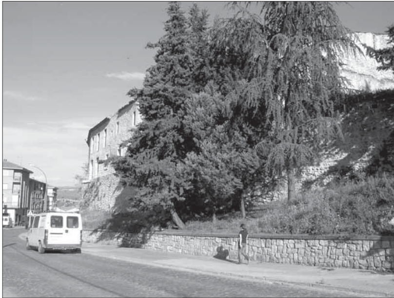
Zona de la muralla sobre la que se intervendrá
