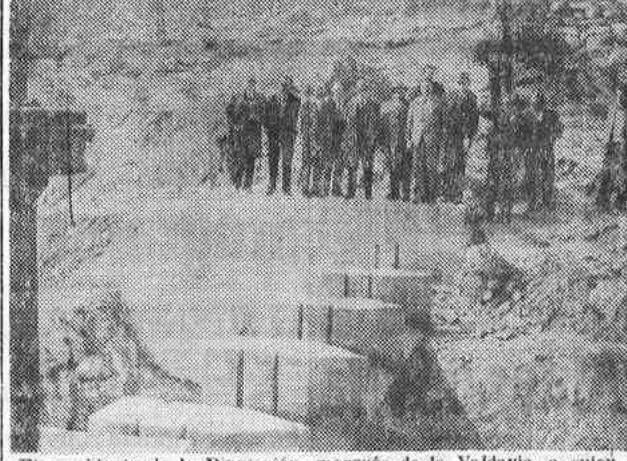
El presidente de la Diputación, marqués de la Valdavia, a quien acompañan diputados provinciales y técnicos de la Corporación, contempla la presa construida y el depósito regulador para el suministro de agua al pueblo de Mataelpino, obras efectuadas por el organismo provincial. (Foto Leal.)
