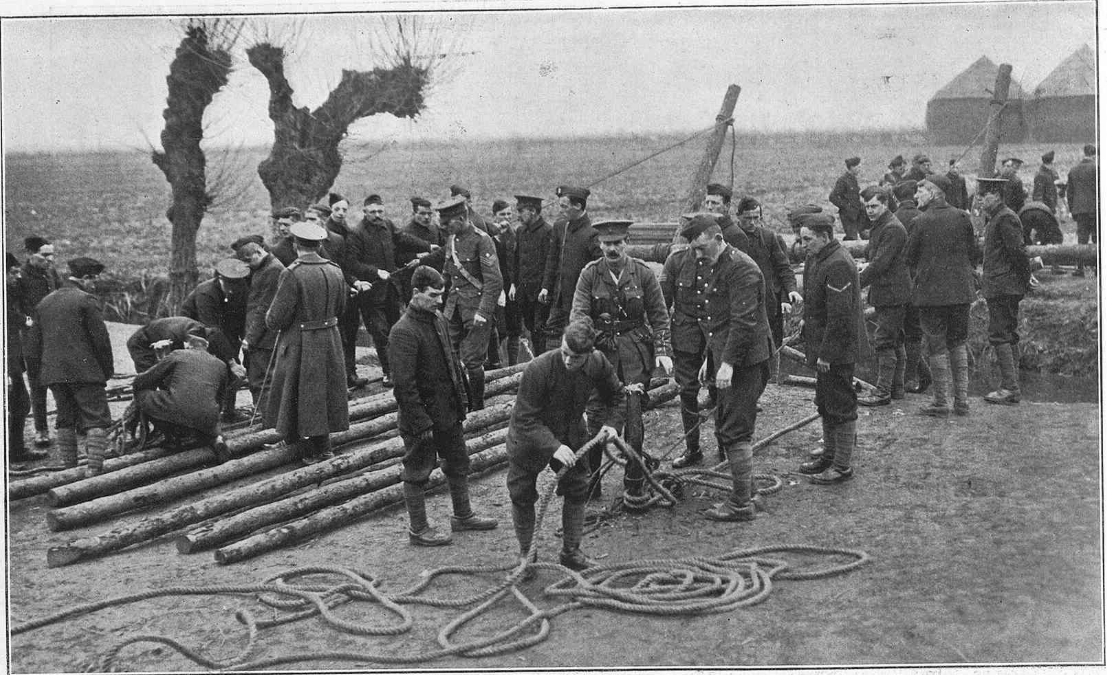
La guerra europea. - Pontoneros ingleses construyendo un puente de troncos para atravesar un río. (De fotografía de R. Parrondo.)
