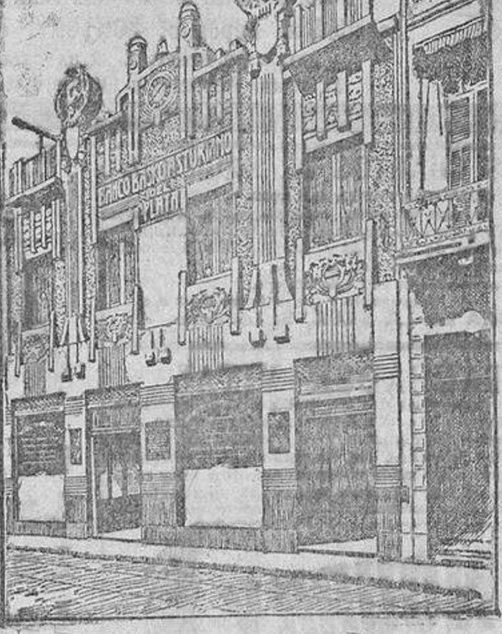
EDIFICIO DEL BANCO
