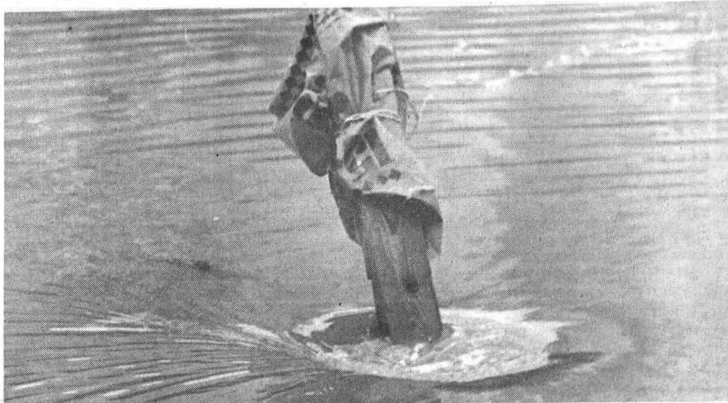
Un palo señala la existencia de una boca de alcantarillado sin su correspondiente trapa
