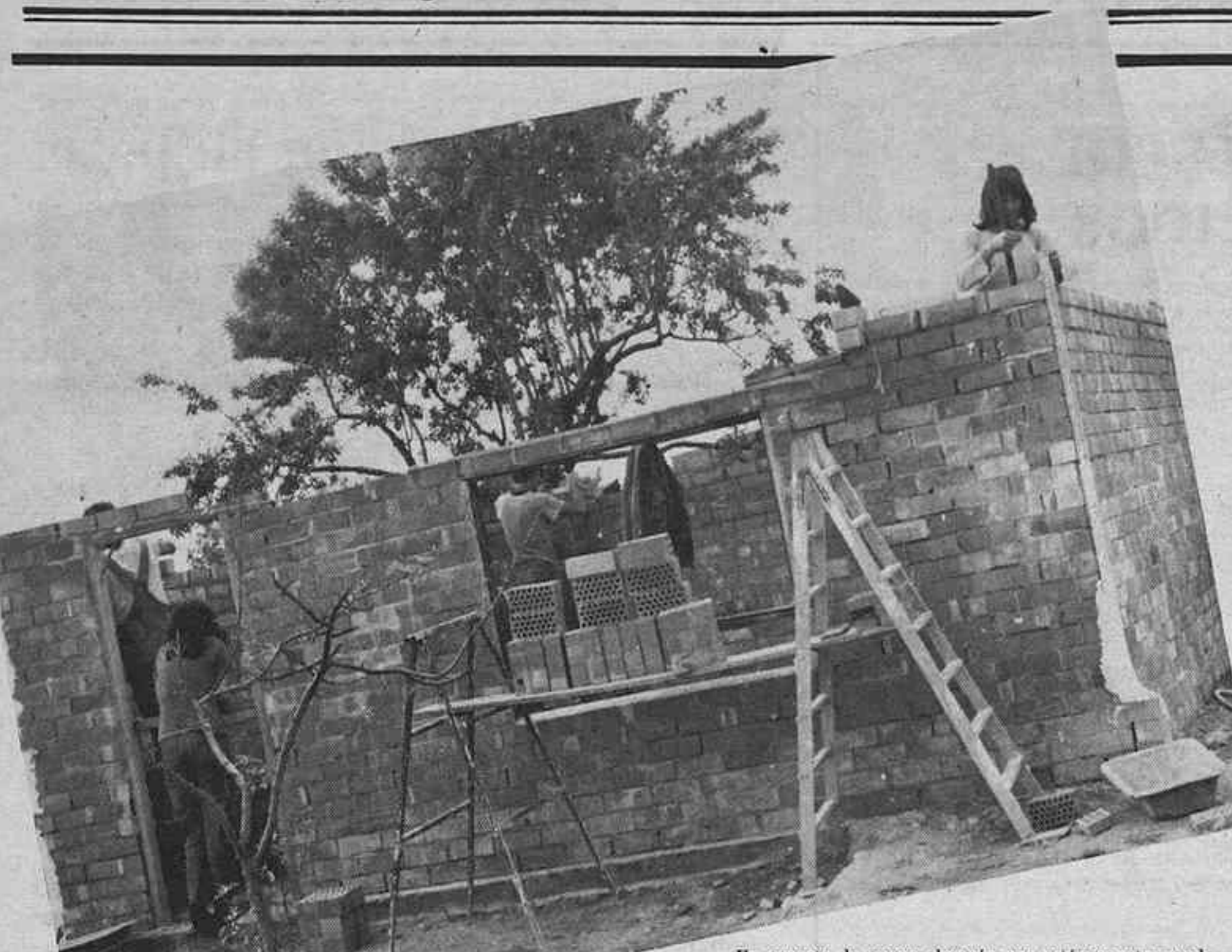
Un aspecto de nuevo almacén que están construyendo.
