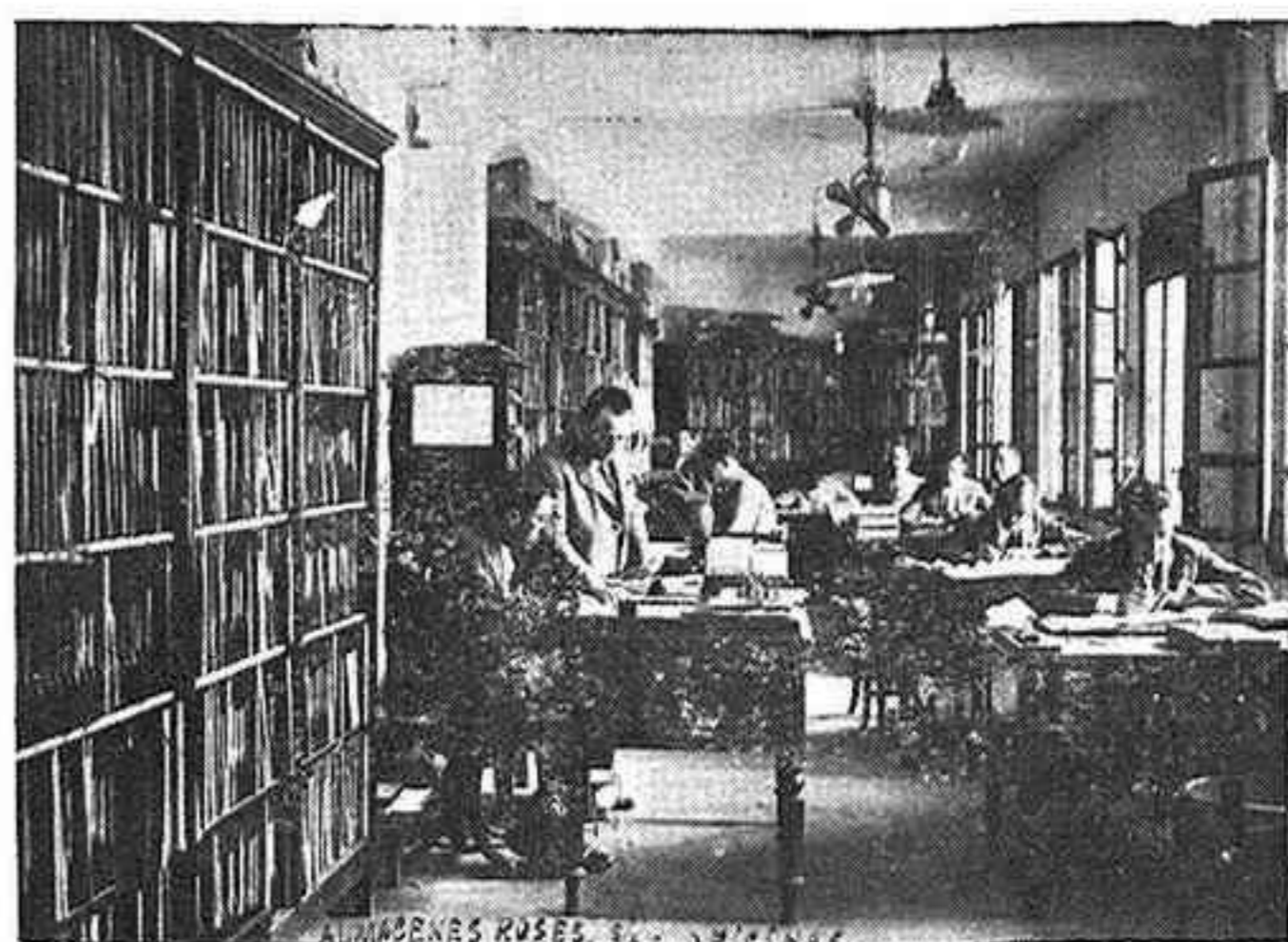
Vista parcial de las oficinas
