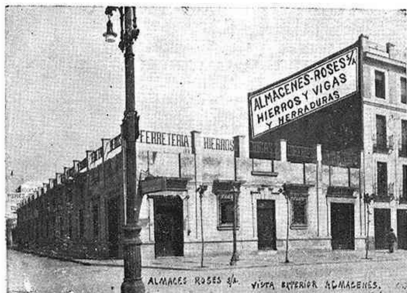
Vista general del edificio
