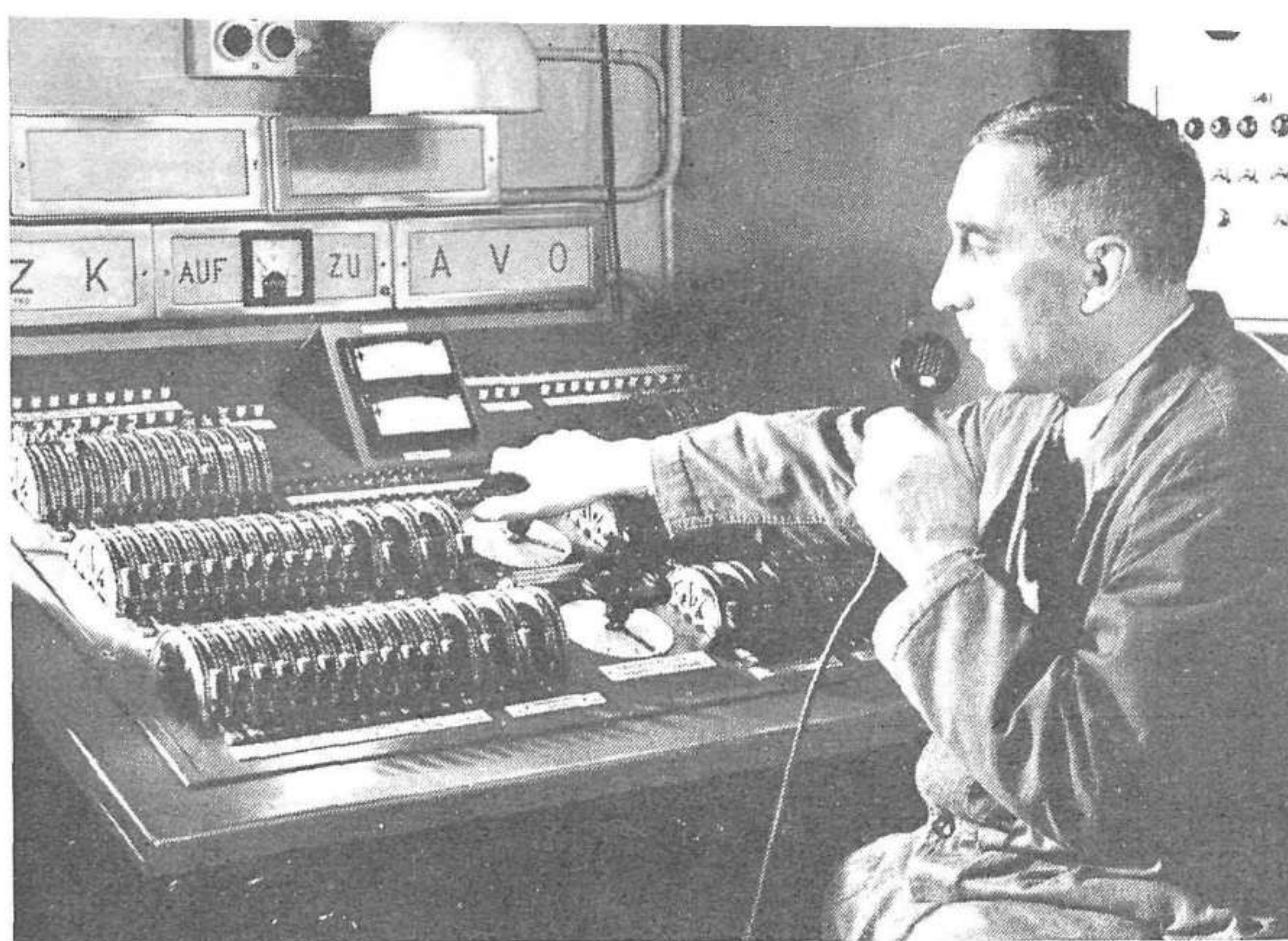
Cabina de mando de la luminotecnia del teatro de la Opera del estado de Hamburgo
