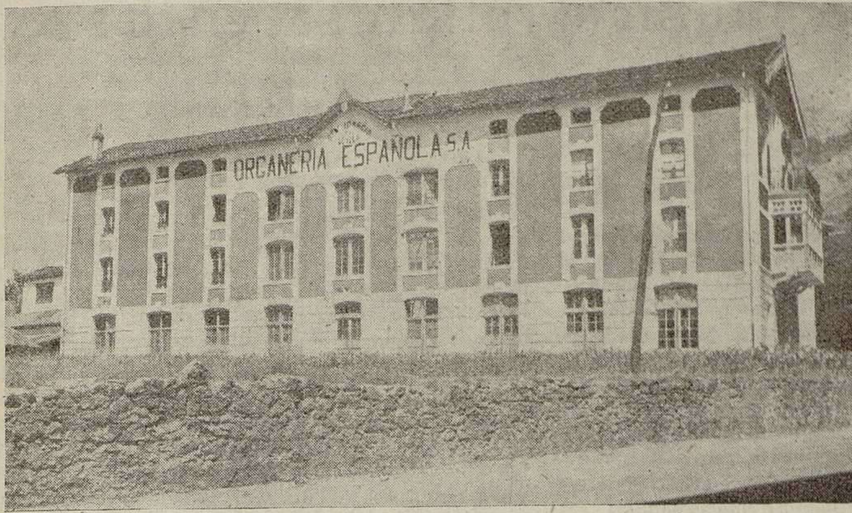
Actualmente: 10 órganos en construcción.
