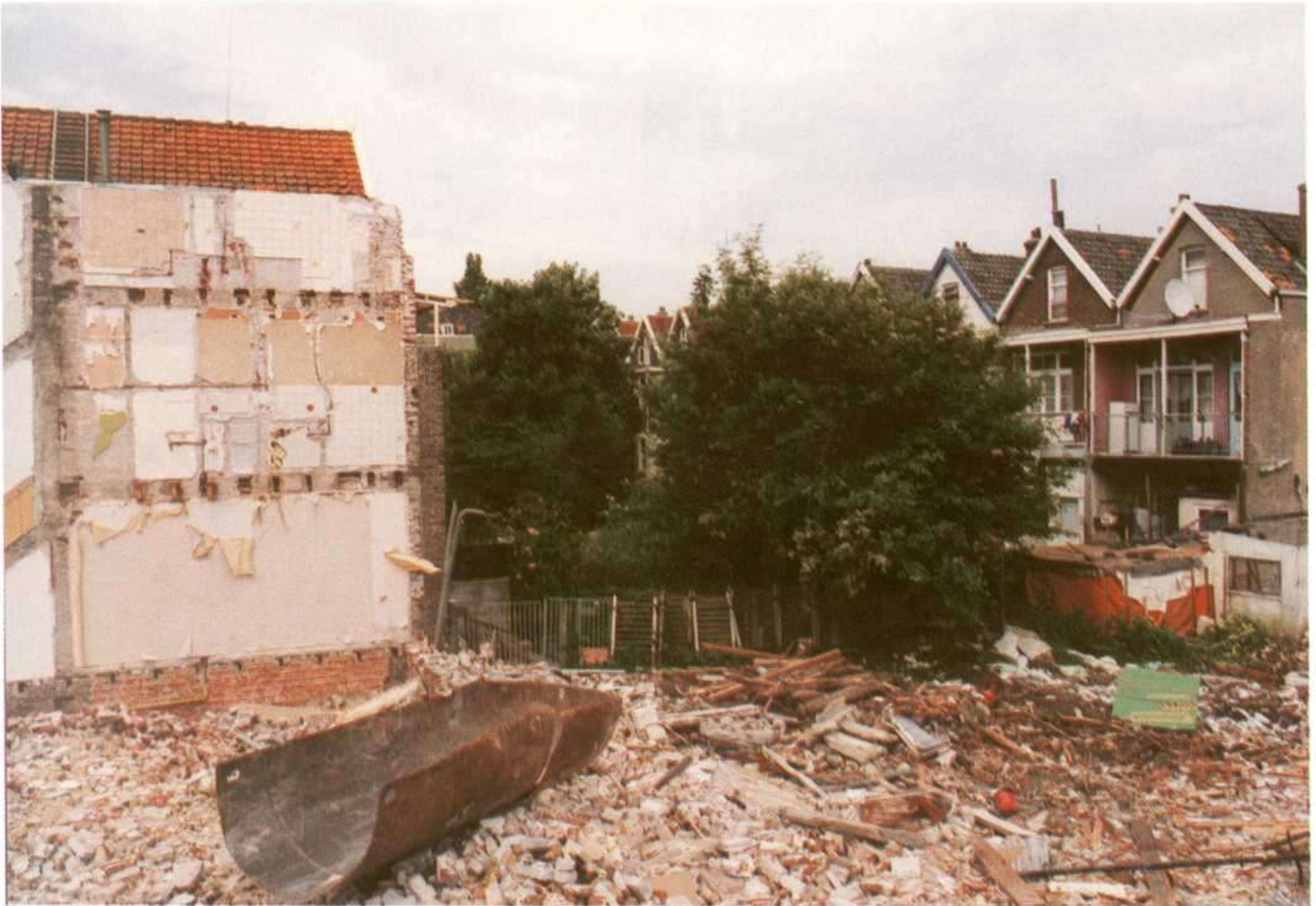
Lara Almarcegui: Demoliciones: Apertura de jardín interior, Róterdam, 1999.
