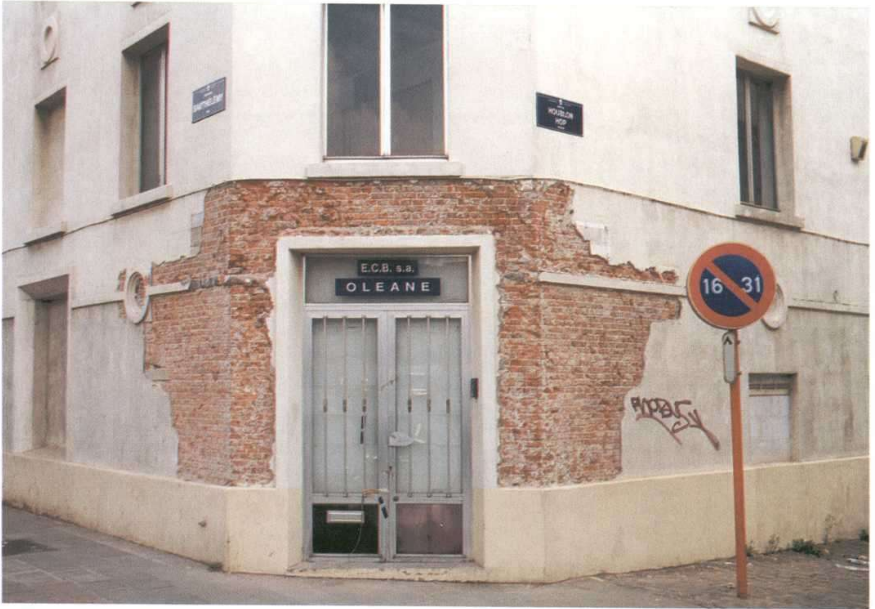
Lara Almarcegui: Retirando el cemento de la fachada, Bruselas, 1999.
