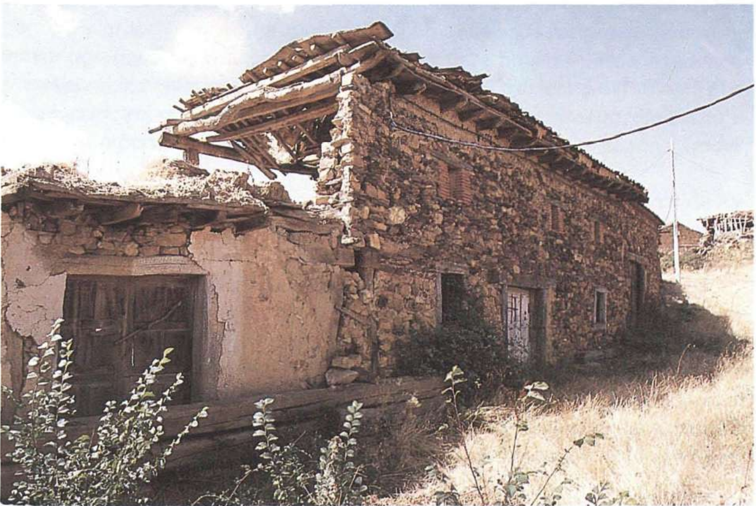
Fot. 11.—Casa construida de piedra y pizarra. Dinteles de pudinga. Villacorta (Segovia).
