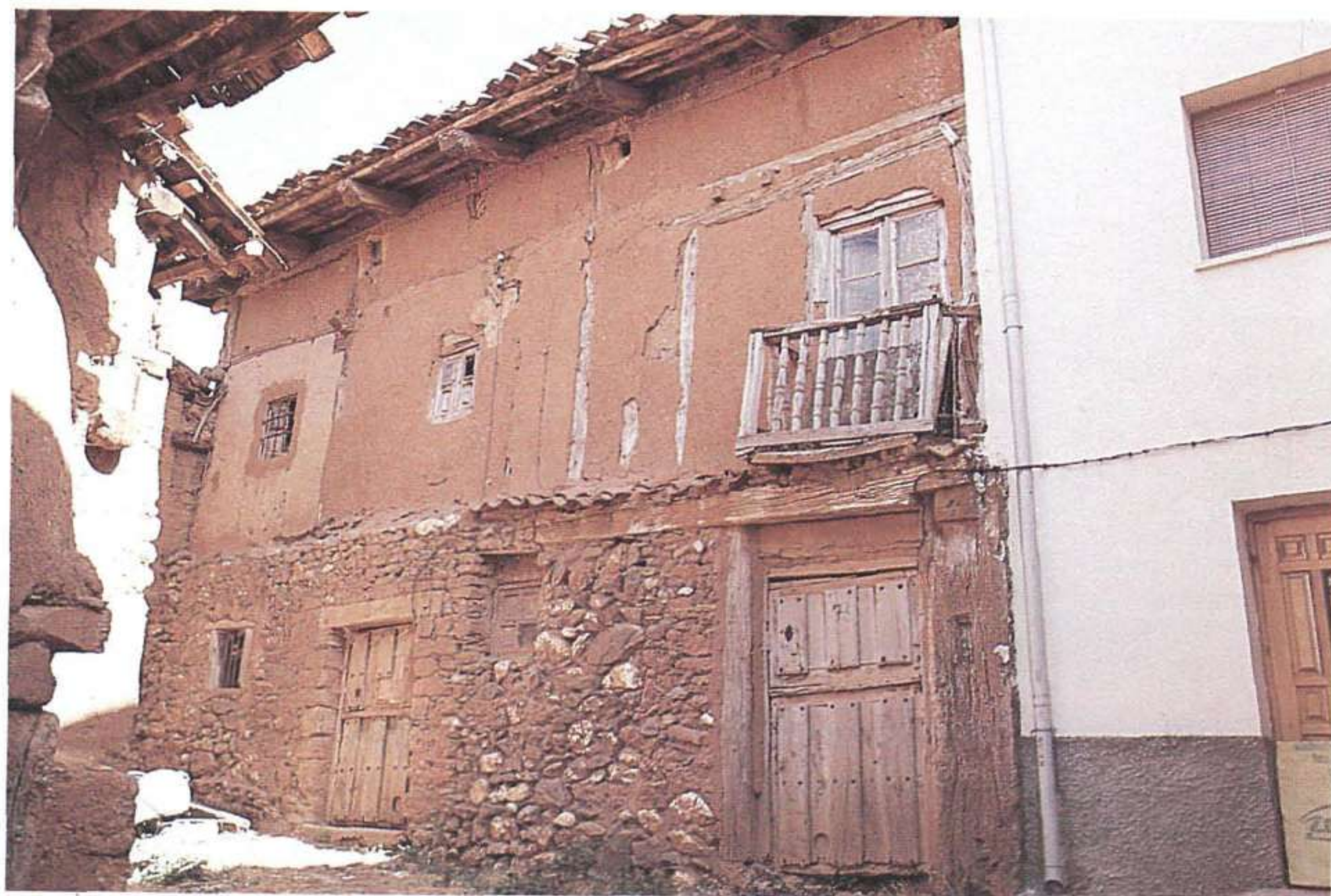
Fot. 9.—Casa con la primera planta de piedra y la segunda de adobe. Abajo, cuadra; arriba, vivienda. Ayllón (Segovia).
