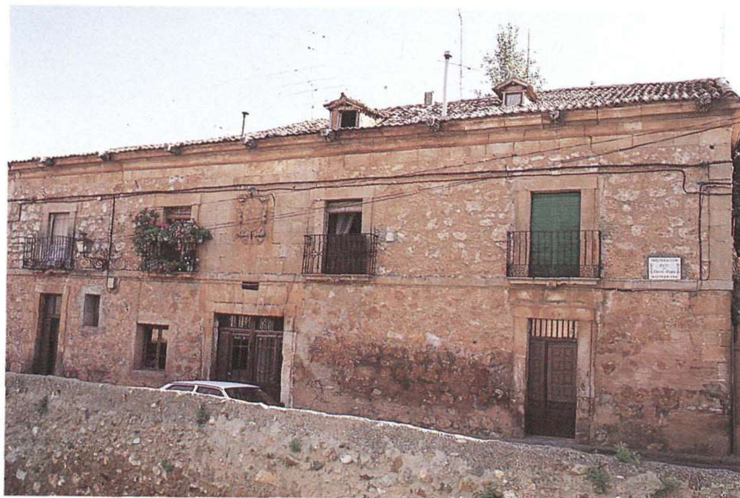
Fot. 5.—Casa construida totalmente de pizarra y argamasa. Dinteles de pudinga. Santibañez de Ayllón (Segovia).
