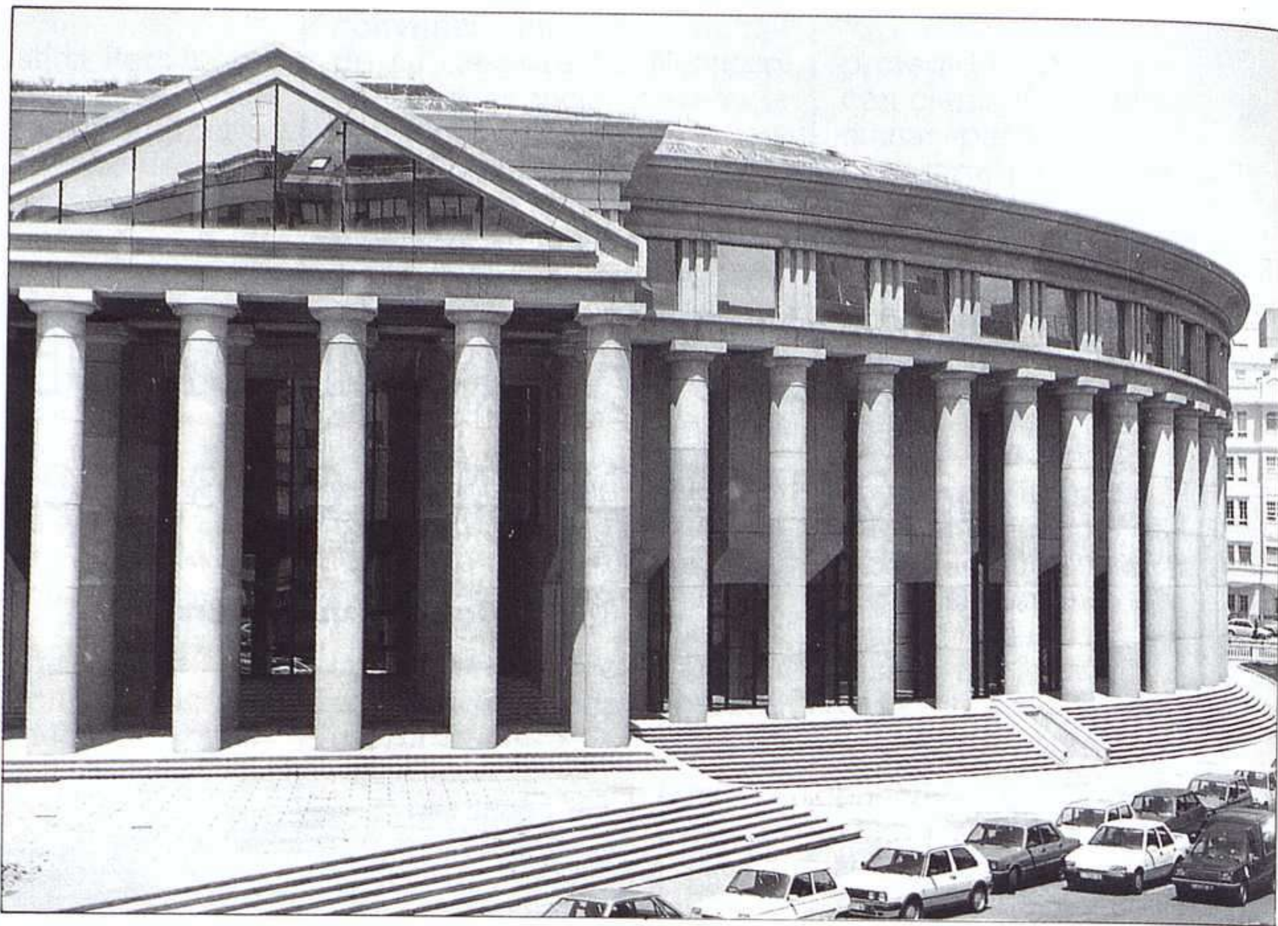
Aspecto del exterior del Auditorio de La Coruña.
