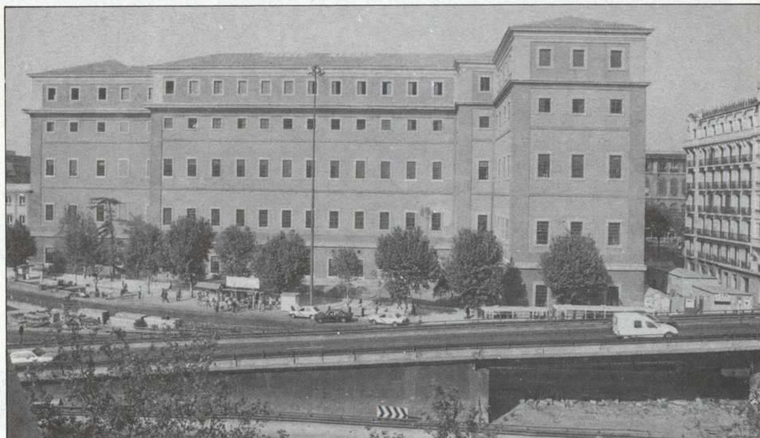
Vista general del edificio que alberga el Centro.
