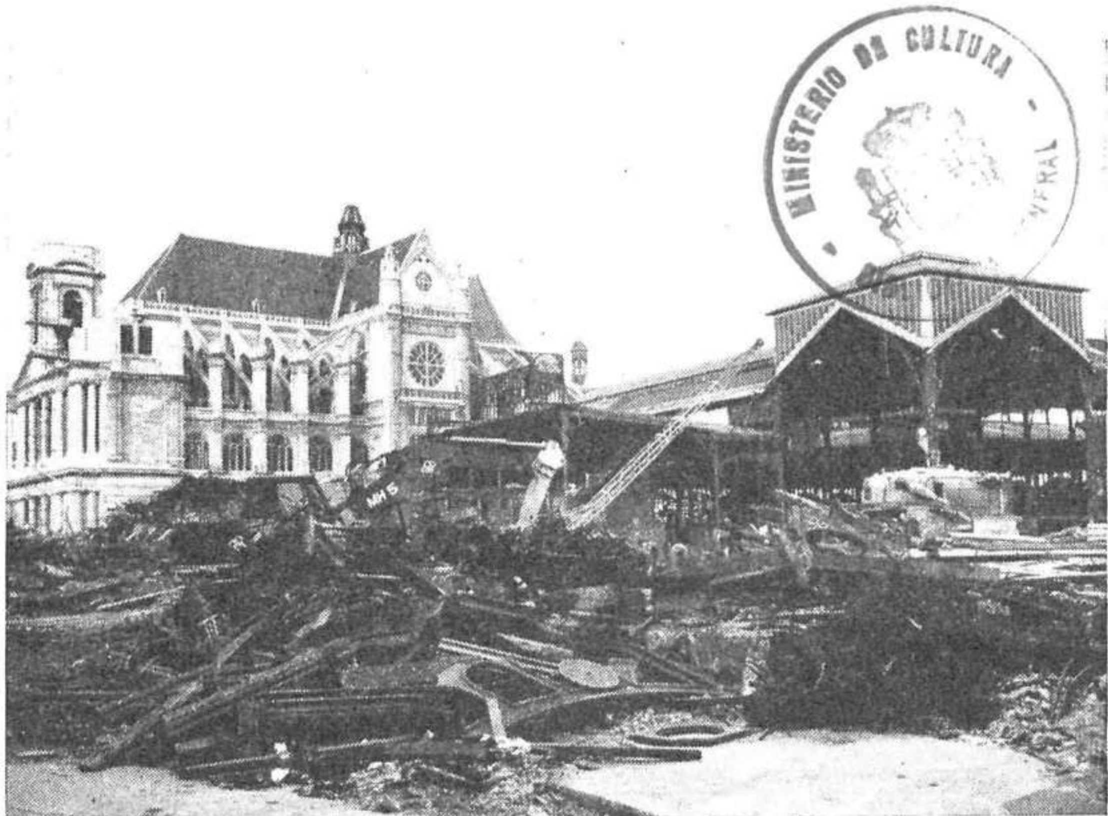
Demolición de los pabellones de Baltard
