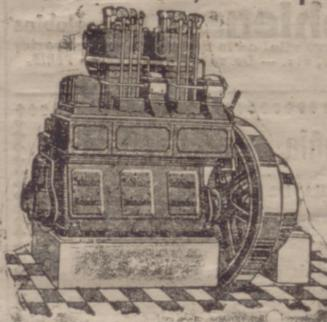
Su puesta en marcha es sencillísima completamente en frío, sin necesidad de medio auxiliar alguno de ignición, por manivela y sin esfuerzo en potencias hasta 28 HP. y por aire comprimido en las mayores.
