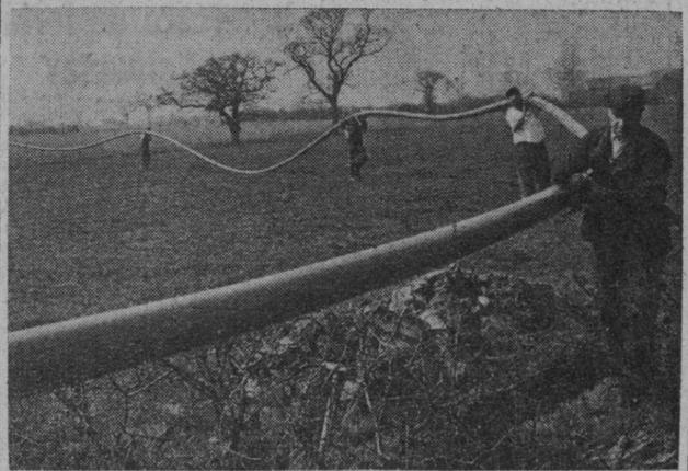
Esto que a primera vista parece una gigantesca serpiente, es un trozo de la tubería de plástico que puede utilizarse para conducciones de agua. Fabricada de cloruro de polivinilo Geon, esta tubería de 10,16 cm. de diámetro, pesa muy poco y posee una alta resistencia a la corrosión
