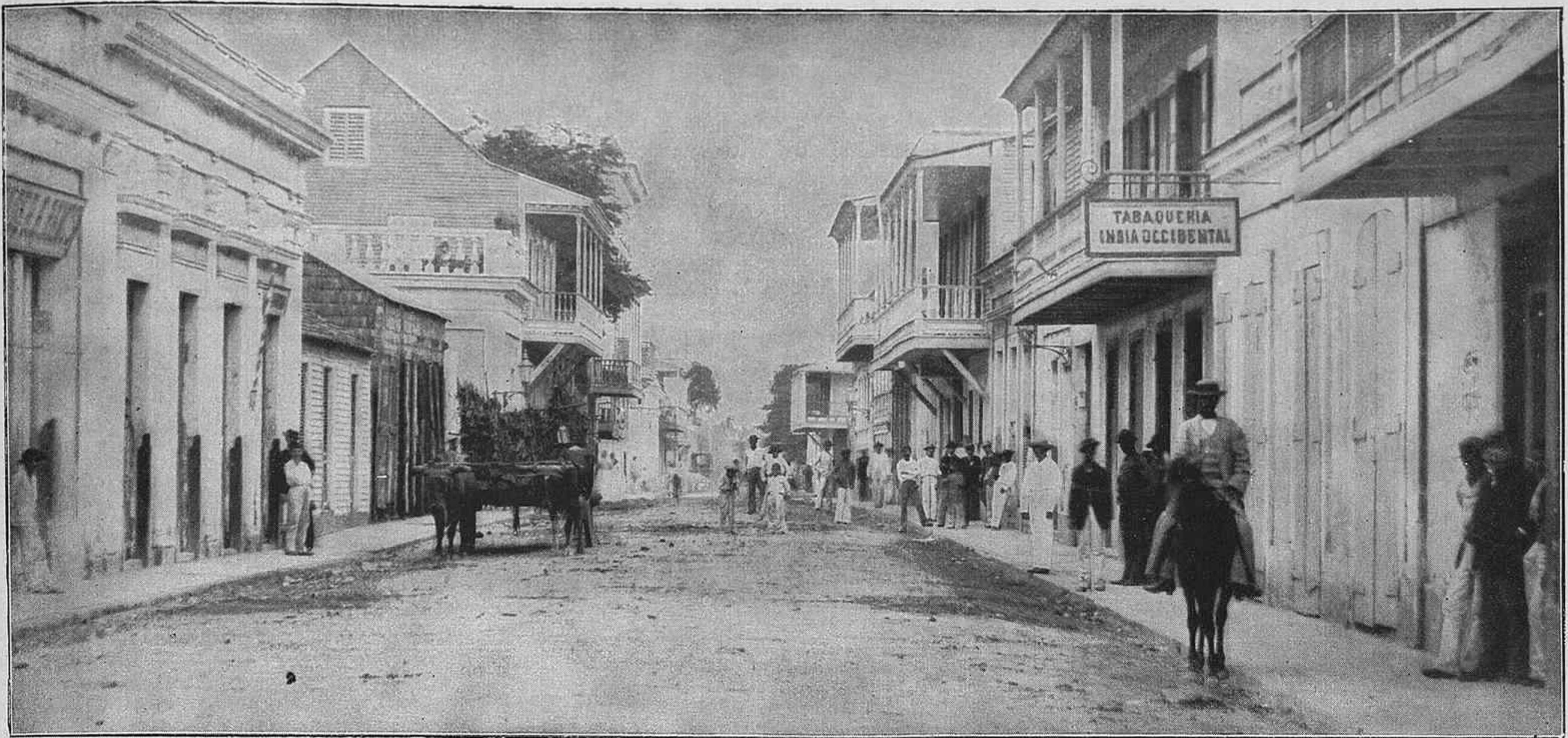
VISTA DE LA CALLE QUE CONDUCE AL MUELLE
