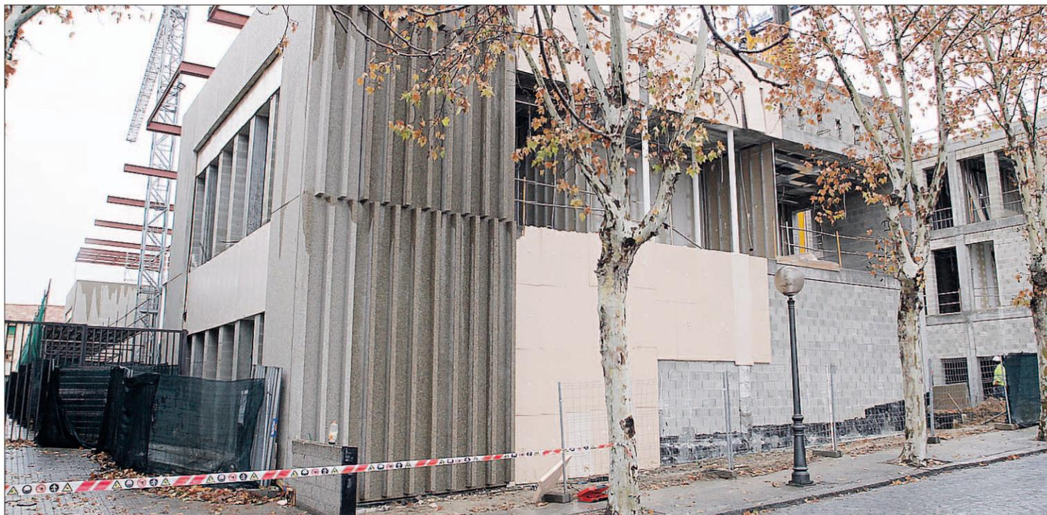
La empresa constructora está instalando sistemas para el aislamiento térmico por el exterior SATE y paneles de poliestireno expandido. / NEREA LLORENTE
