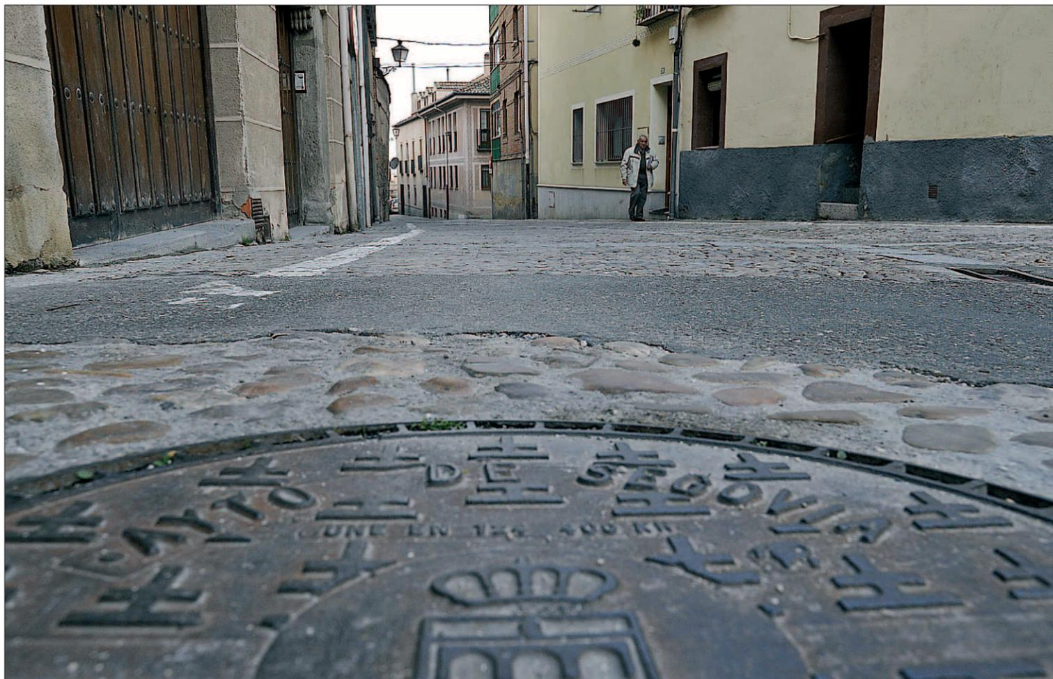
El firme de guijarros será sustituido por adoquín y las aceras, que estarán a la misma altura de la calzada, se construirán con losas de granito. / JUAN MARTÍN
