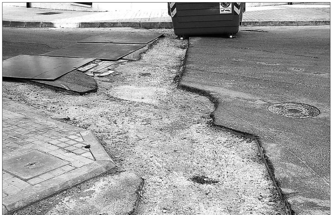
En las calles del pueblo hay zanjas tapadas con hormigón, sin asfaltar, o con placas metálicas./EL ADELANTADO
