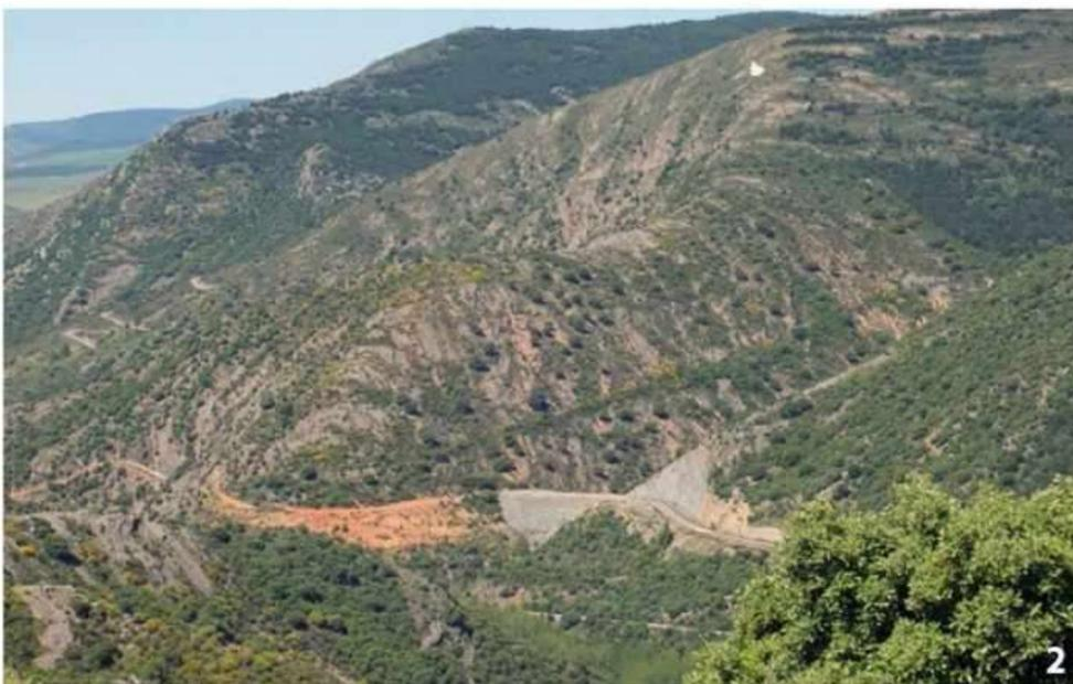
**1.** La cerrada del embalse de Enciso durante la construcción de la presa. Puede observarse la inclinación de las capas hacia aguas abajo de la presa (noreste a la izquierda de la fotografía)
