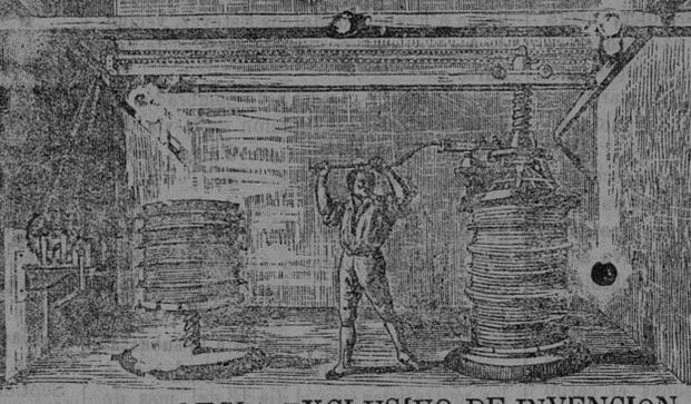
Fúndase este sistema prensas «Cousinou» en la extracción central de los líquidos mediante capachos con agujero en el centro de doble seno, platillos para el buen repartimiento y equilibrio de las cargas y palanca múltiple de doble alternación capaz de dar una presión de 30.000 á 60.000 kilogramos.
