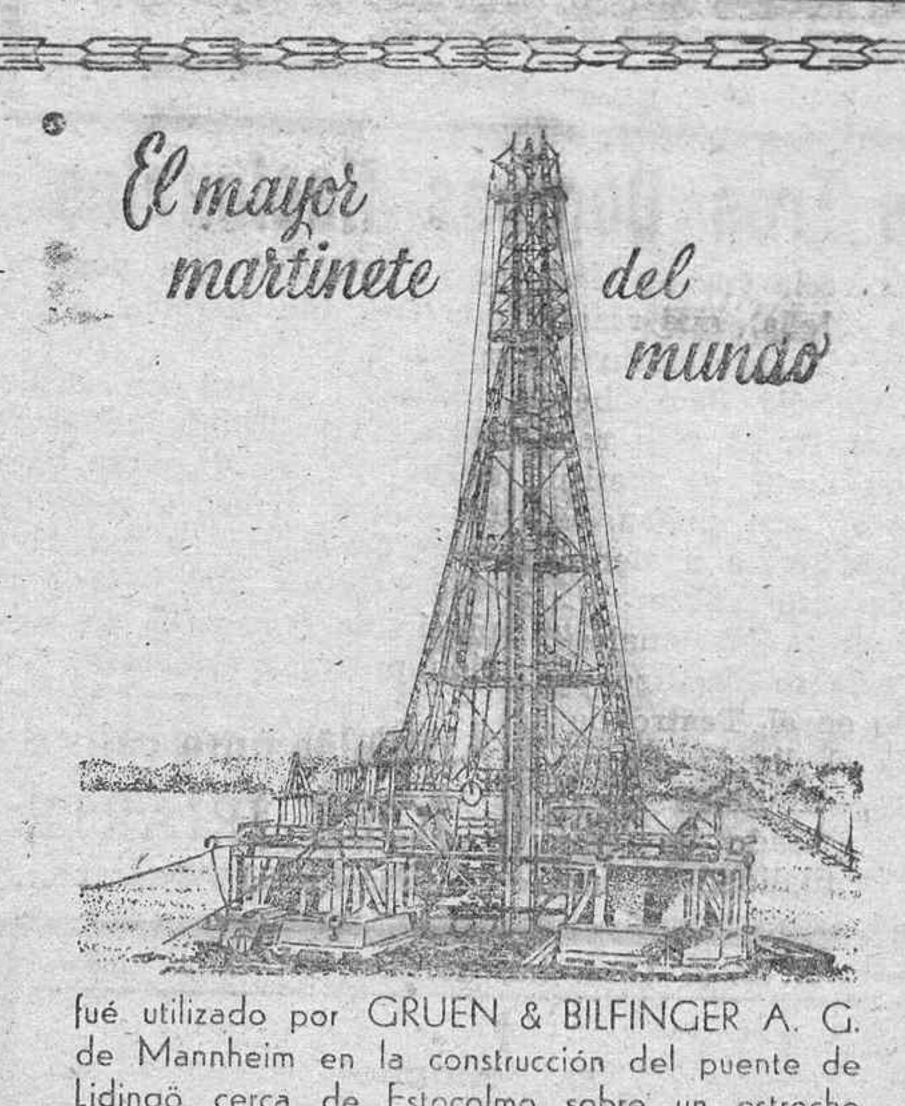
Lidingö cerca de Estocolmo sobre un estrecho de 750 m. de ancho. El martinete colocó en el fondo del mar postes de cemento armado de 40 m. de largo y 1 m. de diámetro.
