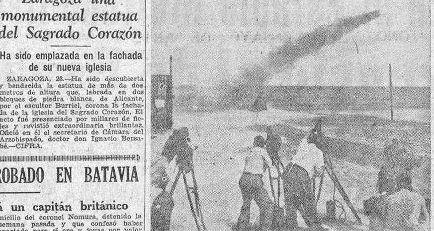
Pruebas en Fort Mills (Estados Unidos) de una bomba a la que se ha dado el nombre de "chimenea volante", de propulsión de cohetes, que alcanza una velocidad superior a los dos mil kilómetros por hora. Las cámaras cinematográficas impresionan el momento del disparo, hecho sobre una rampa de lanzamiento. (Foto Cifra.)
