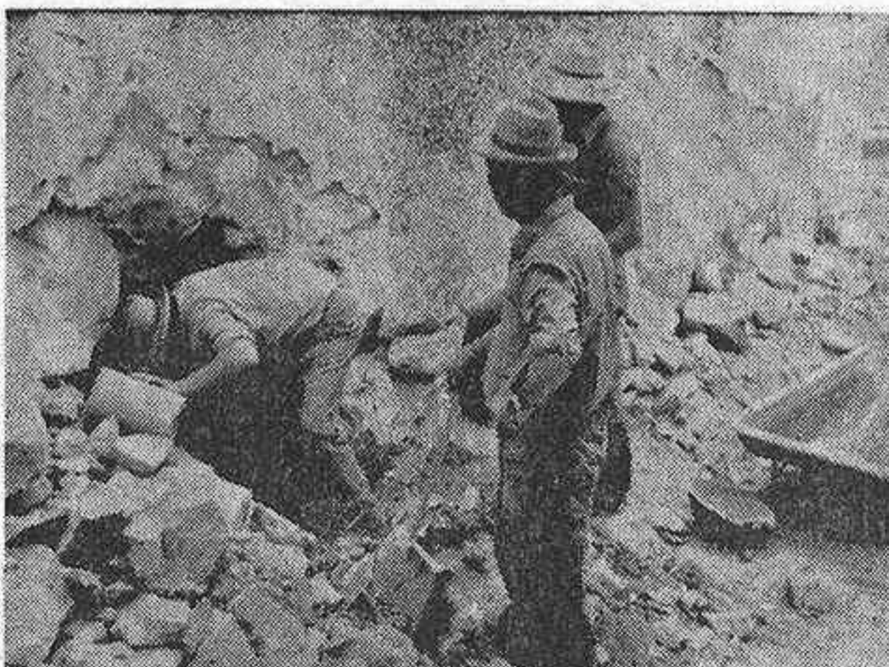
Trabajos en común para conectar la red general para abastecimiento domiciliario de agua potable en Costur.
