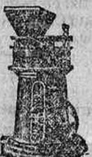
La torre llega con su mecanismo completamente montado, se la coloca en el lugar que ha de ocupar y una hora despues de su llegada el molino puede ya funcionar y moler. El molinero puede añadir
